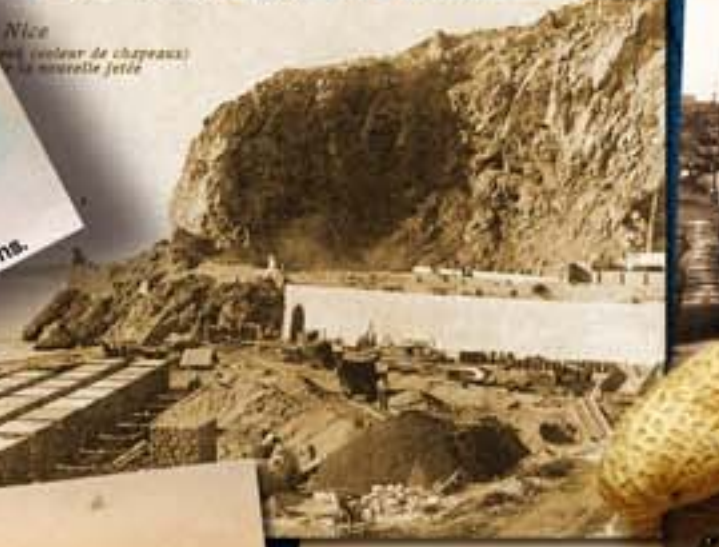
Nice (en couleur de chapeaux) La nouvelle jetée Construction de la nouvelle jetée avec les pierres de la colline du Château. Le monument aux morts prendra sa place dans la carrière.
